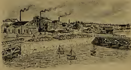
Pumpstation und Mühle.
